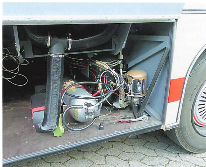
Sollte der Luftpressor einmal ausfallen, dient die 10-Liter-Sauerstoffflasche aus einer Taucherausrüstung als Rückfallebene, in der Druckluft mit 220 bar gespeichert wird. Sie ist direkt vor dem Schutzventil angeschlossen. Das Drucksystem wurde natürlich vom TÜV abgenommen.
